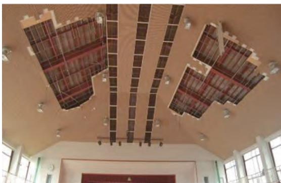
写真一 2001年芸予地震による天井落下被害事例
