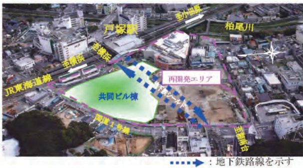
写真一1 戸塚駅西口再開発周辺と地下鉄位置
