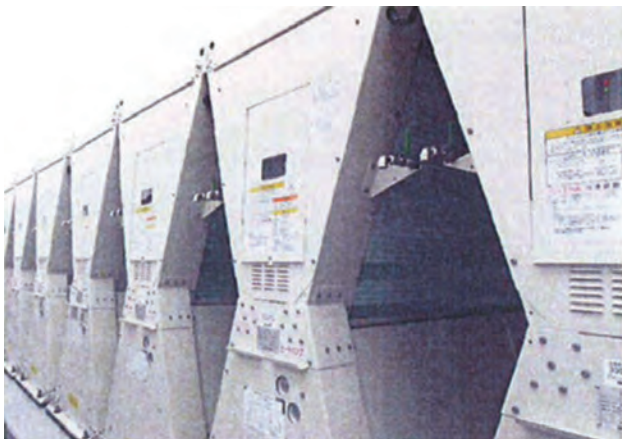
写真-1 空冷ヒートポンプチラー
