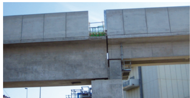
写真ー2 防音壁撤去部（1 km 225 m 左側）
