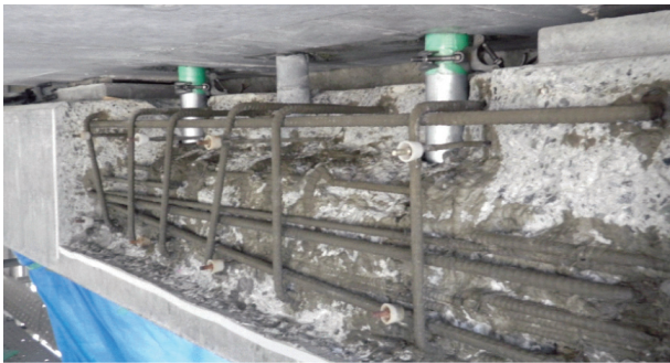
鋼棒の位置固定状況
