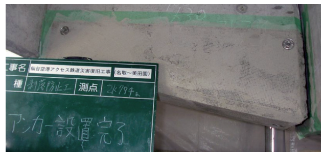
繊維シート貼付・アンカー設置完了 写真-16 PC桁下面の断面修復状況
