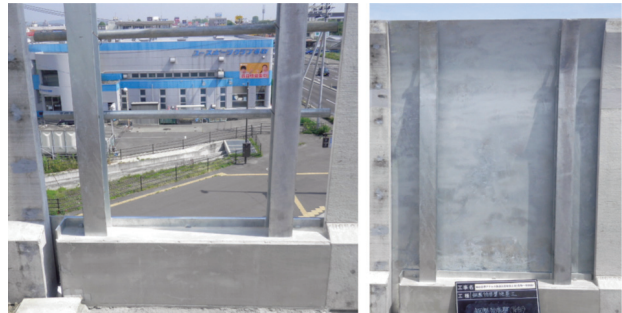
ベースコンクリート打設
