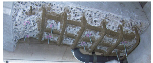
コンクリート研り完了
