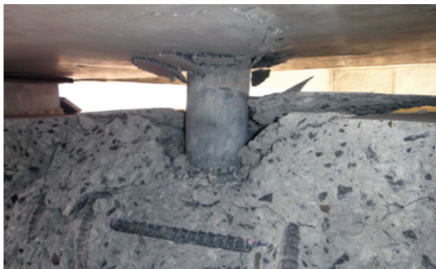
写真-4 ストッパー前面のせん断破壊 (0 km 638 m)
