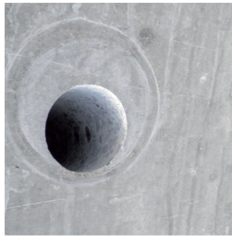
コア抜き完了後
