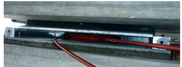
フラットジャッキおよびゴム沓のセット 写真-15 フラットジャッキを用いた再設置
