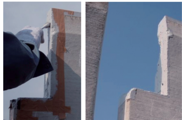
トップコート塗布状況
