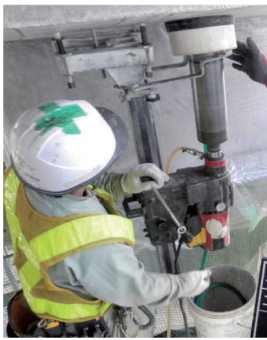
コア抜き状況
