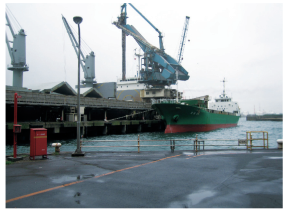
写真一2 岸壁前面の大型桟橋
