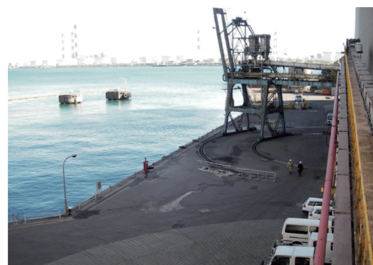
写真一1 矢板式岸壁
