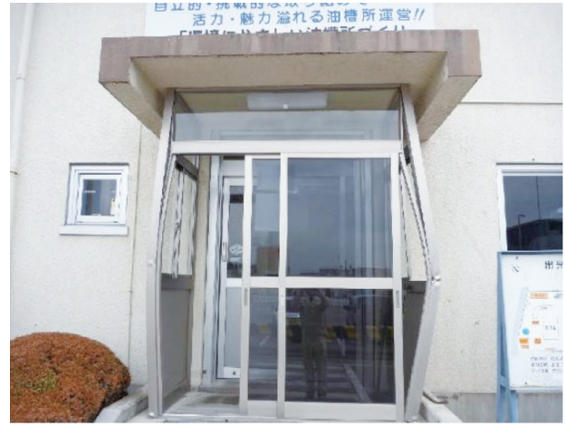
写真-3 エントランス風除室の損傷
