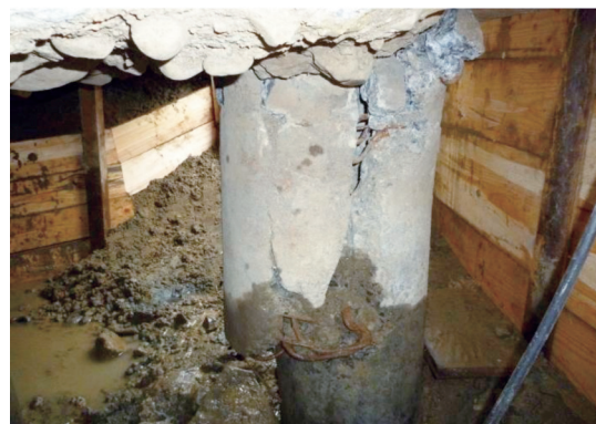
写真一九 杭頭破壊状況
