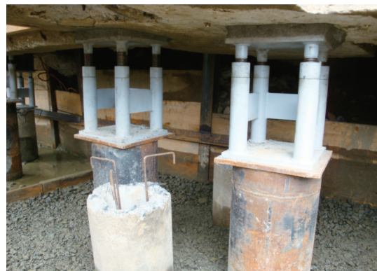
写真一十 杭頭切断整形
