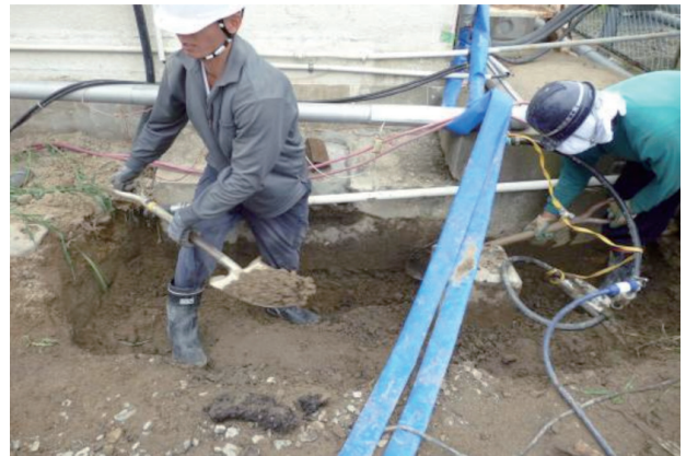
写真一五 事務所裏側の人力掘削
