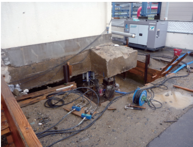
写真-12 油圧配線
