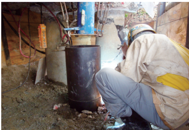
写真一七 鋼管杭継ぎ手溶接
