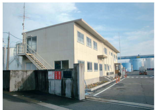
写真-17 完成写真
