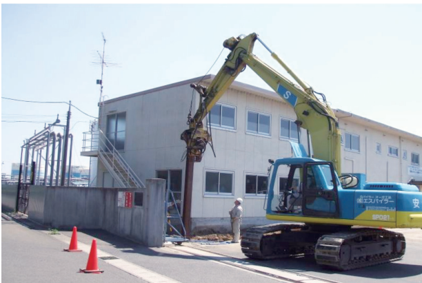
写真一四 山留め親杭打設
