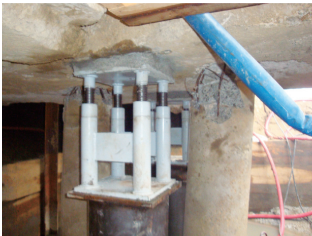
写真一八 鋼管杭圧入完了
