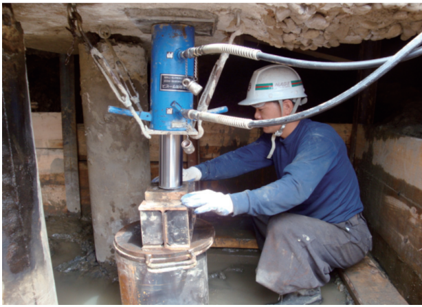
写真一六 圧入状況
