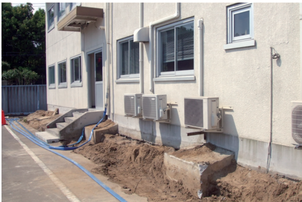
写真一三 空調室外機盛替
