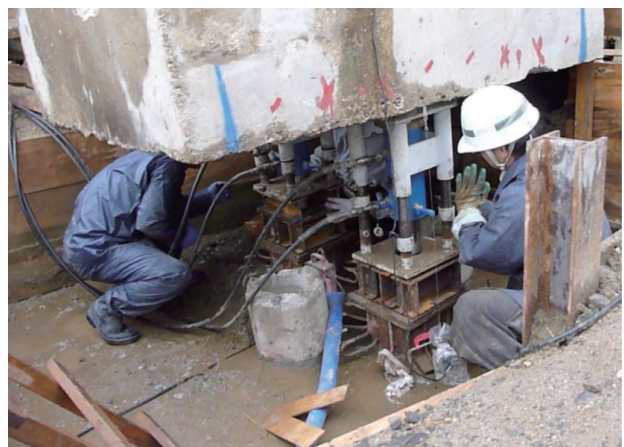
写真-14 ジャッキアップ状況
