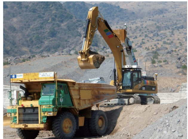
写真一六 超長距離遠隔施工 (試験フィールド側：雲仙普賢岳)
