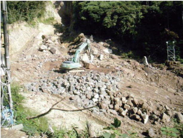
写真一三 中継方式による無人化施工（南大隅）
