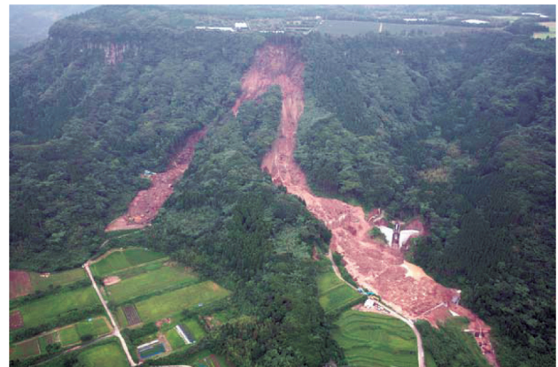
写真一 土石流発生状況
