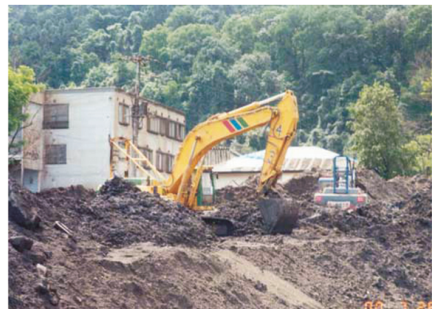
写真一 建設無線による無人化施工 (有珠山)
