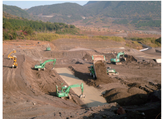
写真一四 無線LANによる無人化施工（雲仙普賢岳）
