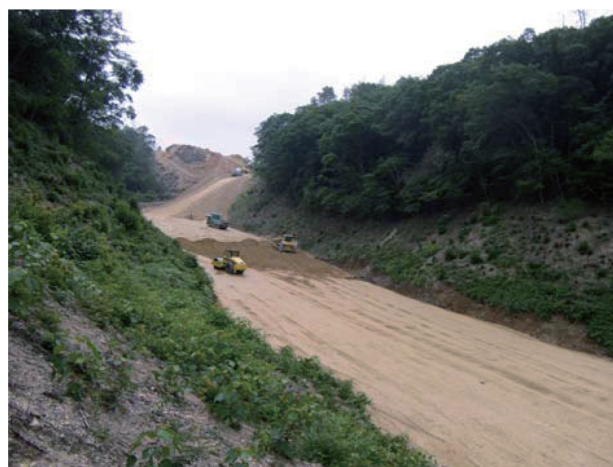
写真-8 盛土状況
