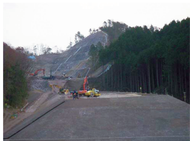
写真一1 盛土状況
