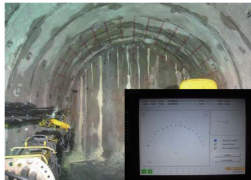
写真一2 コンピュータージャンボによる削孔
