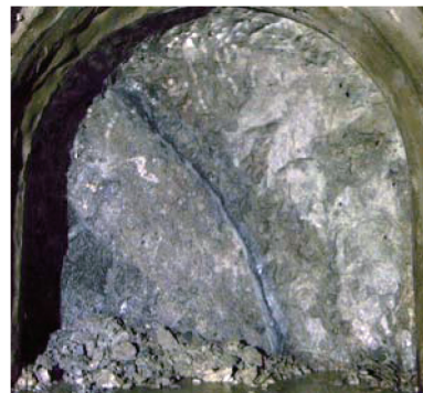
写真一3 強風化岩と新鮮な花崗岩の境界
