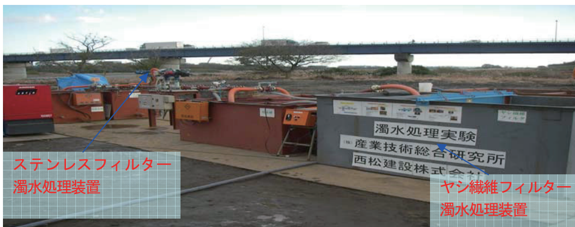
写真-2 工事濁水処理システム実験状況（全景）
