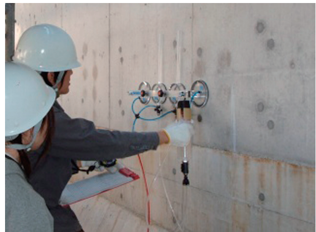
写真一2 測定状況
