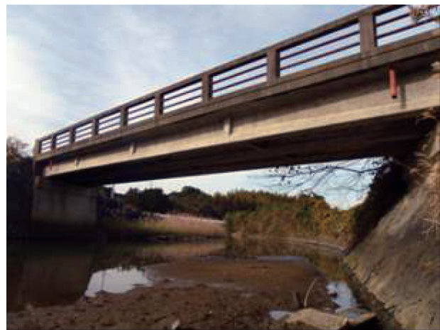
写真一 5 実験に使用した橋梁
