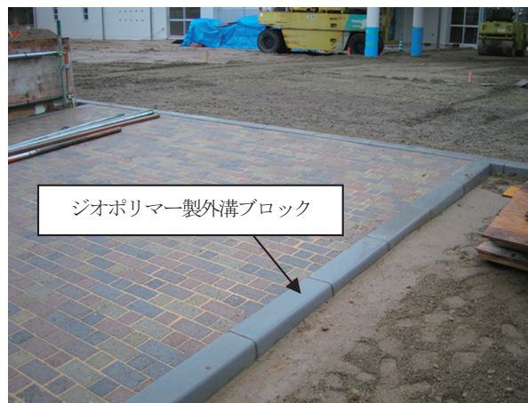
写真-3 設置状況
