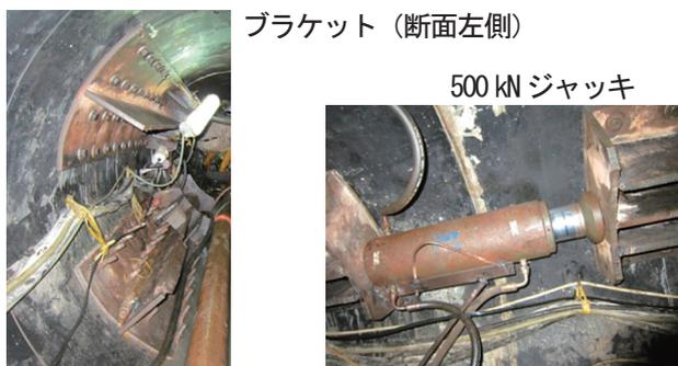
写真一2 ジャッキセット設置状況
