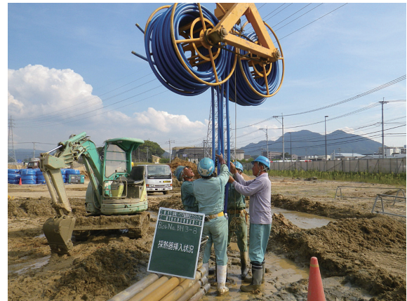
写真二 熱交換器挿入
