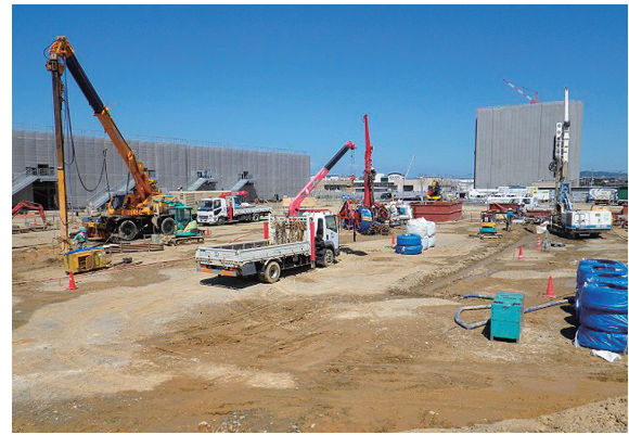
写真一 施工状況
