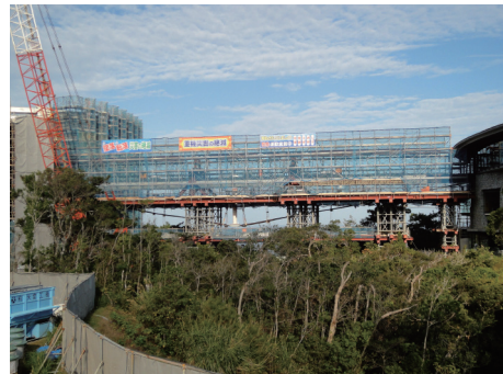
写真一3 施工状況写真
