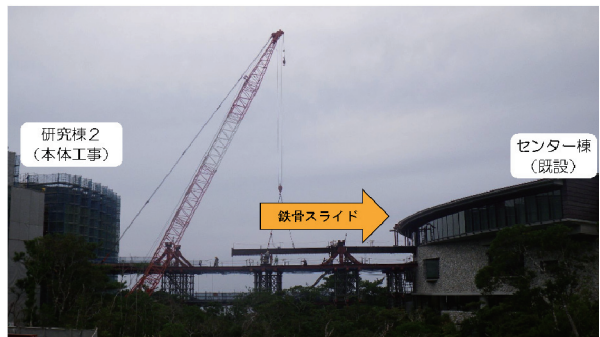
写真一 鉄骨スライド状況
