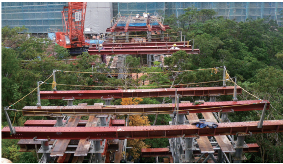
写真一2 最小限の伐採での施工
