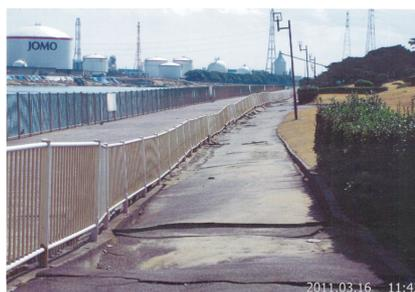
写真四 対策工未施工範囲被災状況
