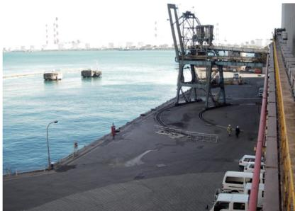
写真一 控式鋼矢板岸壁
