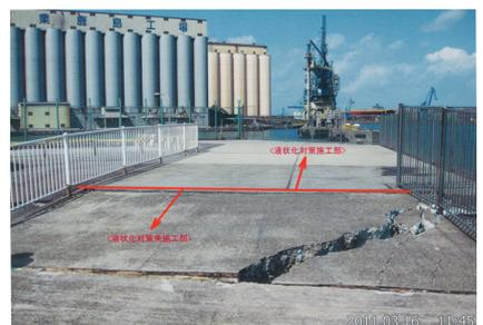
写真五 対策工施工範囲・未施工範囲境界
