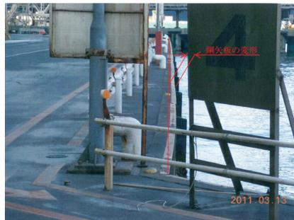
写真二 岸壁頭部変形状況
