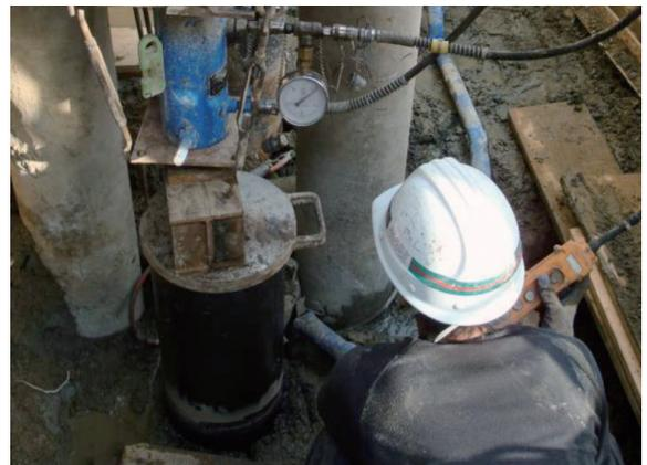
写真二 鋼管杭圧入
