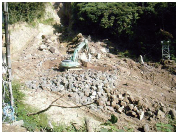
写真二 無人化施工状況
