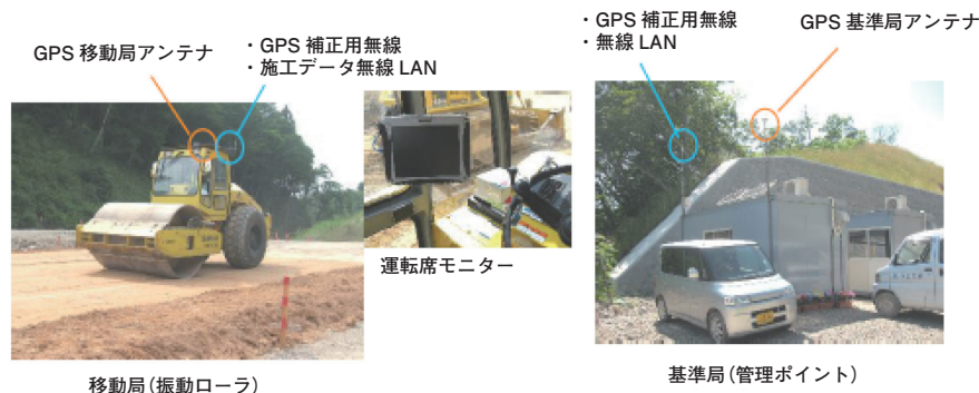
写真-1 締固め機械 (移動局) と基準局 (管理ポイント)
