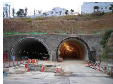
写真一 トンネル起点側坑口部の全景
