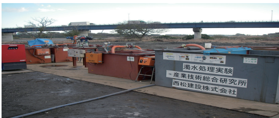
写真一 工事濁水処理システム実験状況 (全景)
