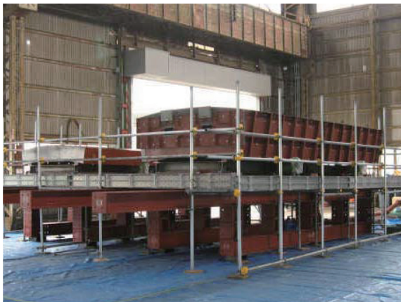
写真一 天端模擬型枠
