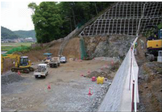
写真一 出口側坑口法面の音響放射面測定時の状況
