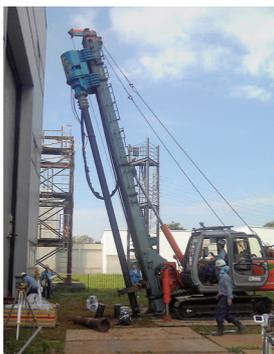
図二 回転貫入鋼管杭（斜杭）の施工状況
