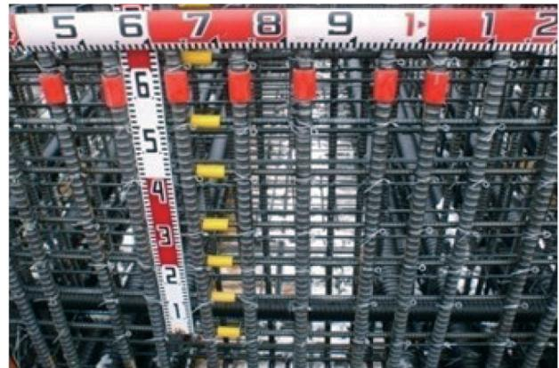
写真一2 鉄筋・シース管配置状況
