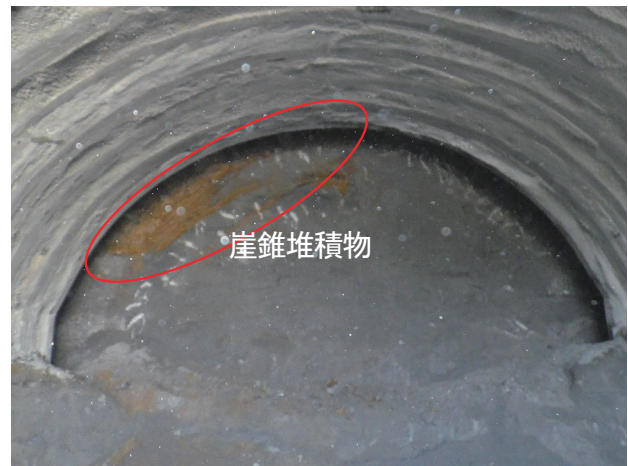
写真-6 切羽 (No.315+65) の状況
