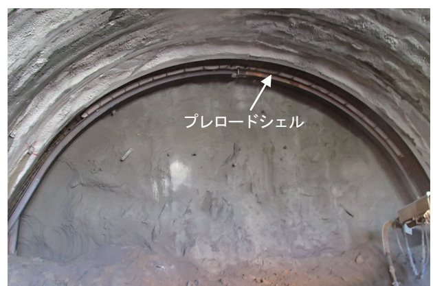
写真-3 プレロードシェル施工状況
