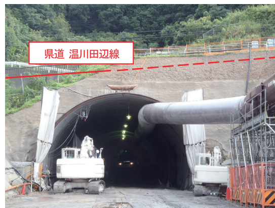
写真一 トンネル坑口部の外観
