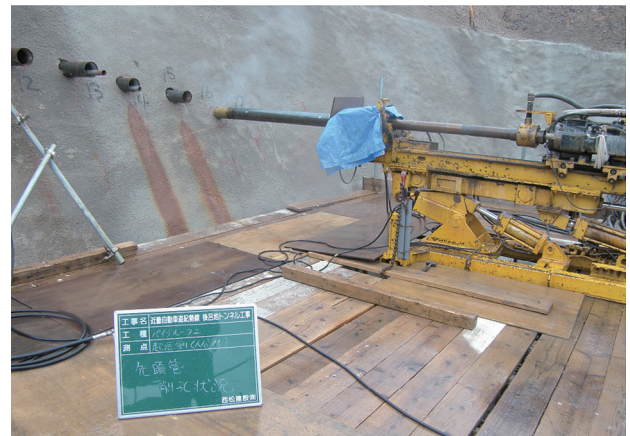
写真-2 パイプルーフ施工状況
