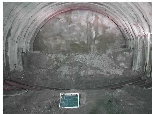
写真-4 一次インバート施工による早期断面閉合状況
