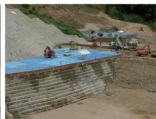
写真-4 2班体制施工状況
