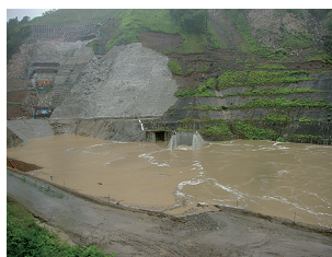
写真-3 出水災害状況
