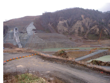
写真一6 右岸上流法面保護工完成全景
