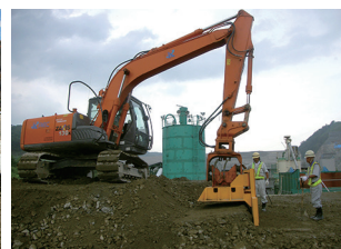
写真-5 法肩締め固め機械による確認試験
