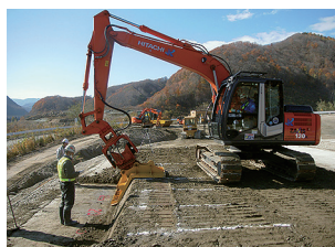
写真-5 法肩締め固め機械による確認試験
