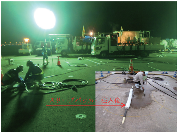
写真一八 スリーブパッカー注入状況
