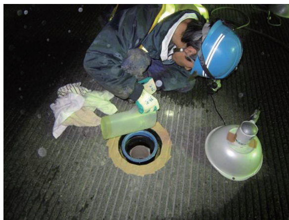
写真-3 樹脂材注入状況
