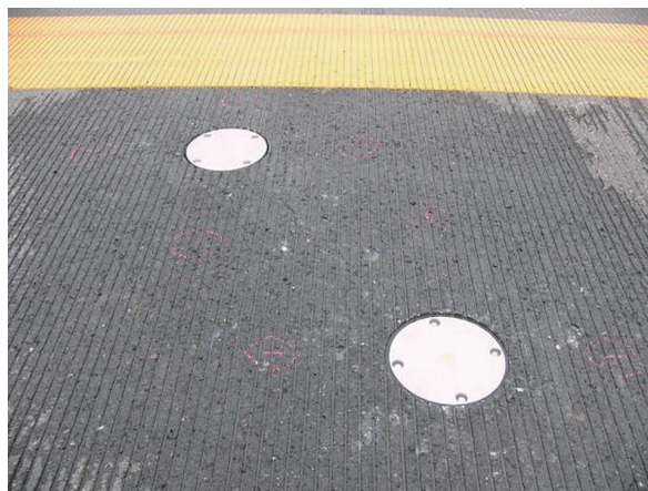
写真-4 防護キャップ設置完了(調査孔用)
