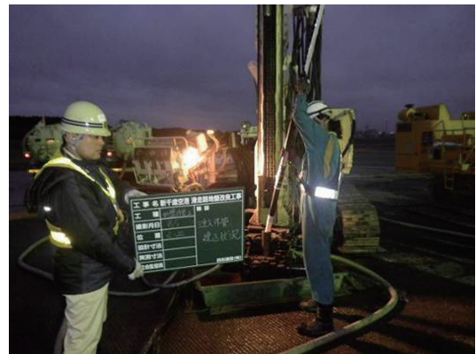
写真一七 注入外管建て込み状況
