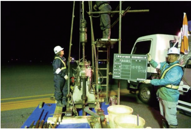
写真一五 事前調査ボーリング
