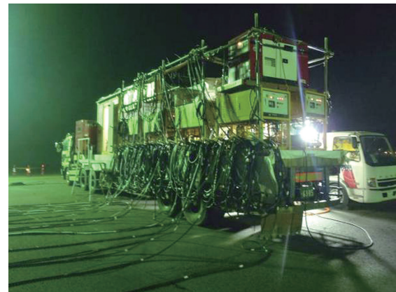
写真一十 浸透固化車上プラント(16セット)
