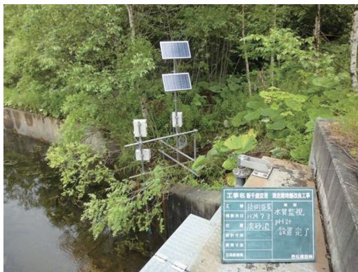
写真-12 自動pH測定器 (美沢川函渠下流部)
