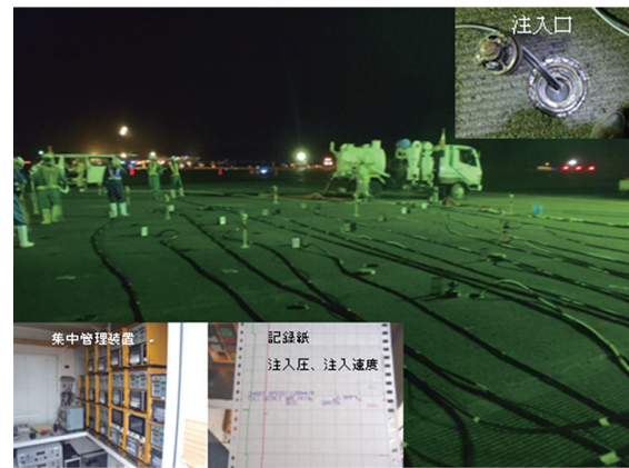
写真一九 浸透固化注入状況
