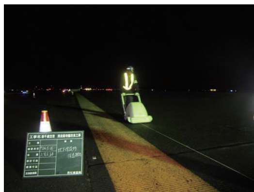
写真-1 エスパー探査状況
