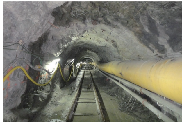
写真-4 レール工法横坑の様子
