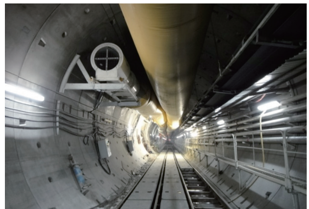
写真-2 本坑レール配置状況
