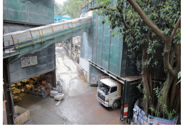
写真-1 坑口の防音ハウス
