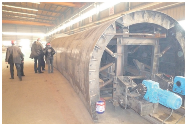
写真一7 型枠工場検査 (天津工場にて)
