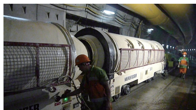
写真-5 ミキサー台車連結状況
