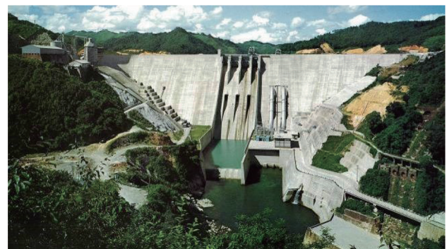
写真一 完成直後の鶴田ダム
