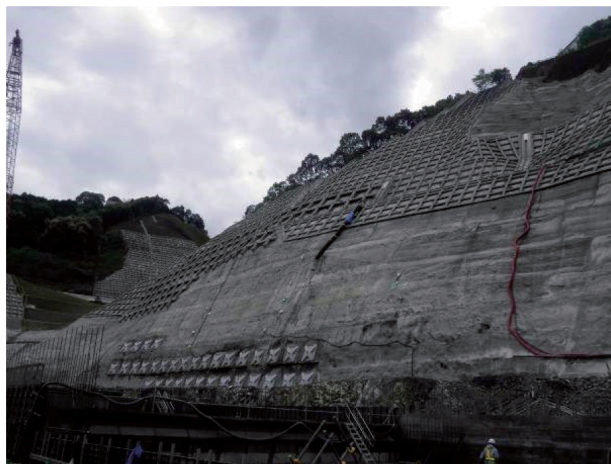
写真-4 PCアンカー施工完了写真 (34本)
