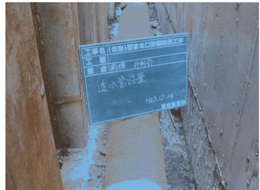
写真一4 透水管設置状況
