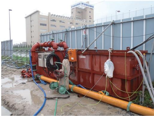
写真一2 ノッチタンク設置状況
