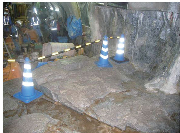
写真-3 テスト場所とした試験坑道の状況
