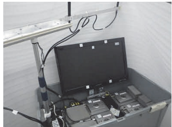
写真-3 コントロールボックス
