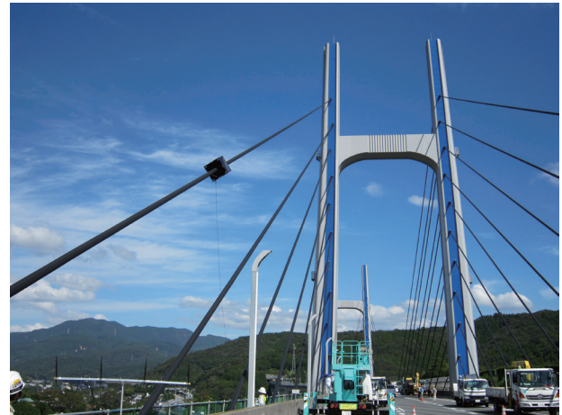
写真一5 調査状況
