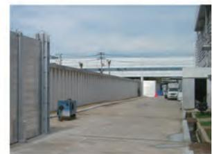
鋼矢板突出式止水壁
