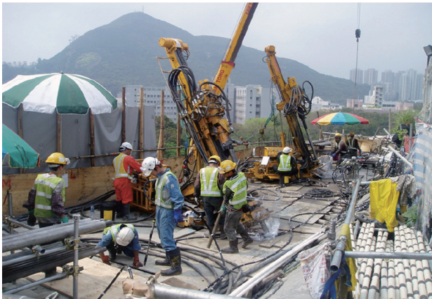
写真一 削孔状況
