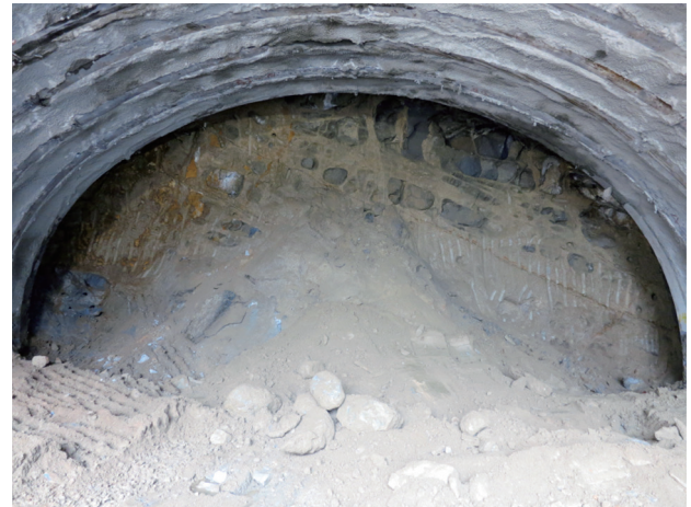
写真二 坑口部切羽状況
