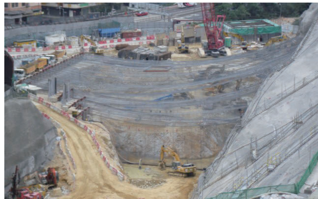
写真-4 発破防護 (Roof-Over方式)
