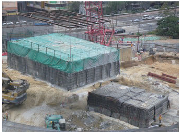
写真-3 発破防護 (Cage-in-Cage方式) 設置状況
