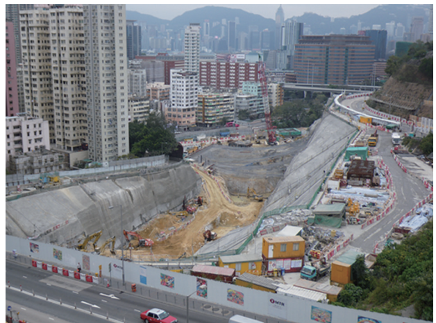
写真-1 市街地での何文田駅掘削状況
