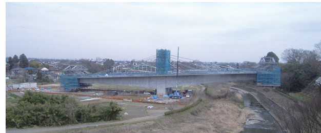
写真-1 斜吊り架設併用張出し架設状況
