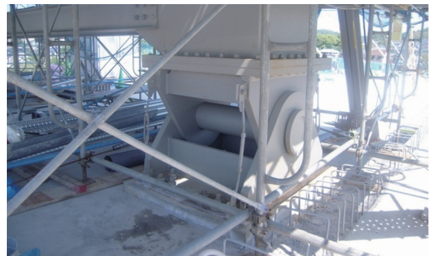
写真-3 ピロン支柱下部ヒンジ構造
