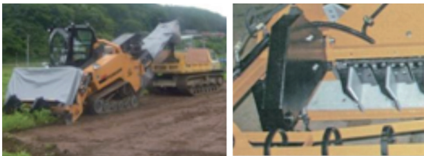
写真-4 スキマー工法
