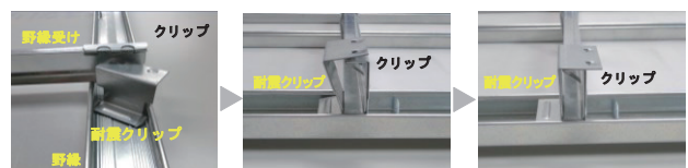
写真-4 耐震クリップの取付け手順
