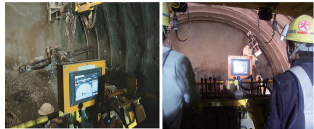
写真一2 モニター設置状況
