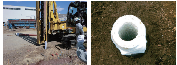
写真-3 ドレーン材の埋設完了状況
