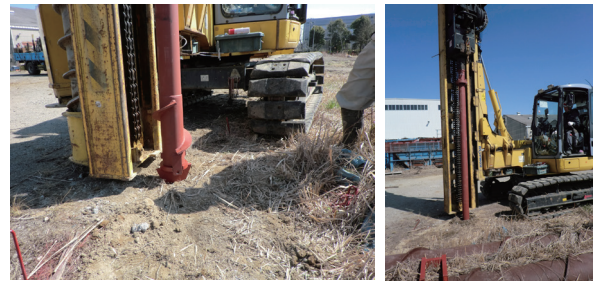
写真-2 ケーシング、先端ビッド及び削孔状況
