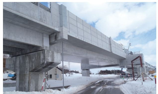
写真一 完成写真
