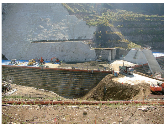
写真三 CSG打設状況
