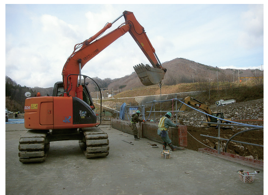
写真二 法肩部の施工状況
