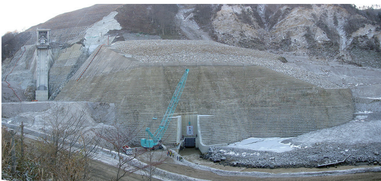
写真一 貯水池内押え盛土施工完了状況
