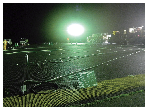
写真二 薬液注入状況
