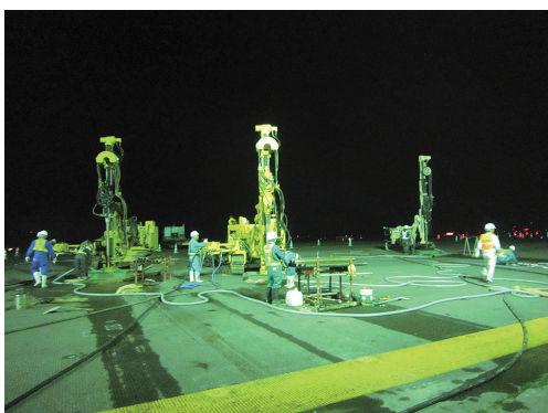
写真一 削孔状況
