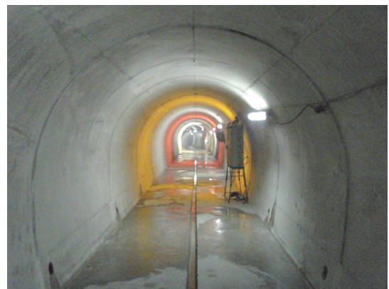
写真二 二次覆工完了状況
