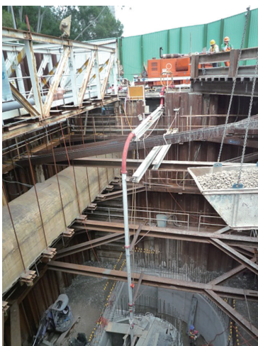
写真三 立坑からコンクリート圧送
