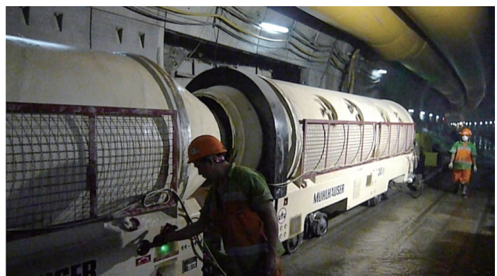
写真四 本坑内でのコンクリート運搬
