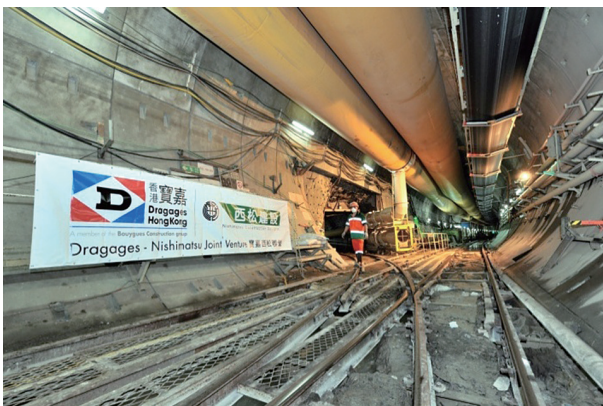
写真一 本坑の様子
