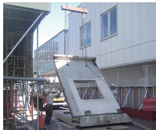
写真-4 PC玉掛状況
