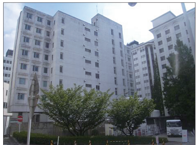
写真一 減築前
