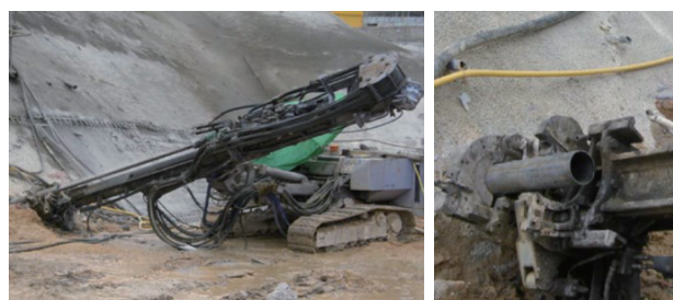
図-10 ソイルネイル施工状況（ケーシング併用）
