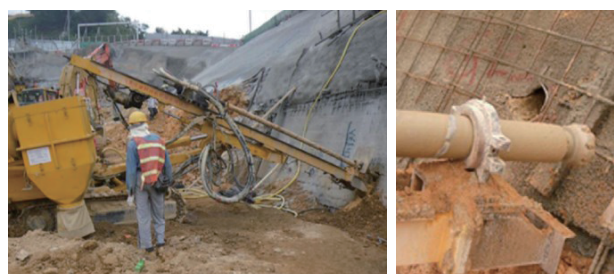
図-9 ソイルネイル施工状況（ケーシングなし）
