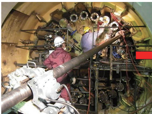
写真-1 凍結管削孔状況
