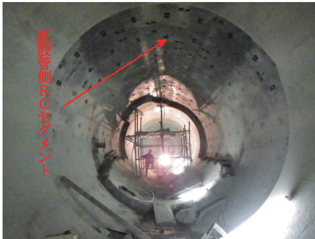
写真-3 二次覆工斫り状況
