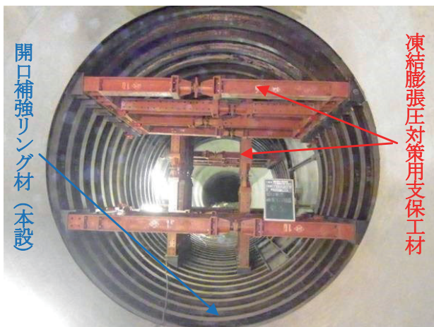
写真-4 内部補強鋼材
