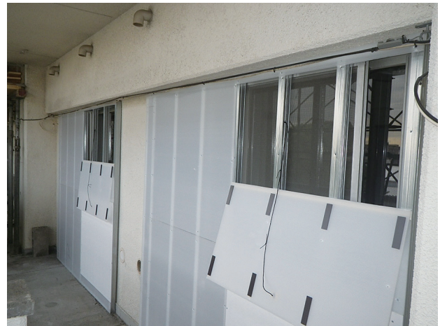
写真-3 バルコニー側の窓養生
