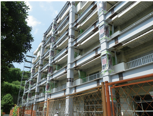
(c) バルコニー側建方完了 写真-1 制振鉄骨フレーム建方
