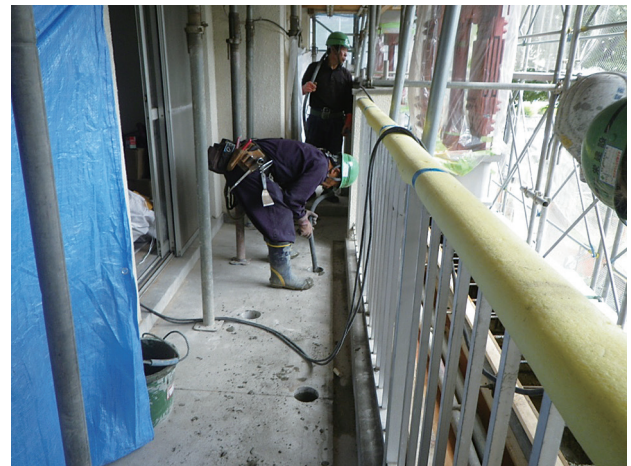
(b) コンクリート打設 写真-2 増設スラブ工事
